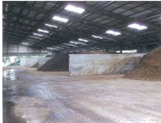
堆積式発酵槽
