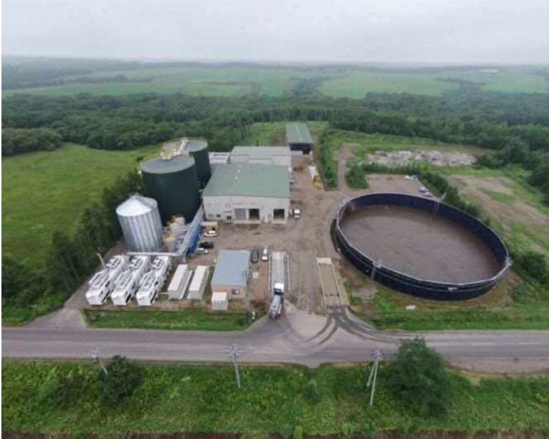
図4 別海バイオガス発電株式会社空中写真
