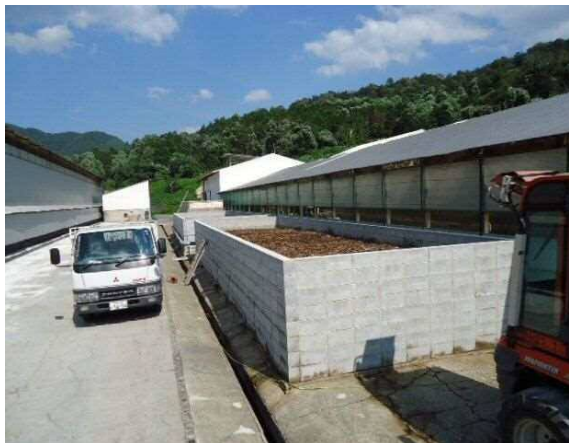
写真3 養鶏場堆肥化施設に設置された アンモニアガス脱臭装置
