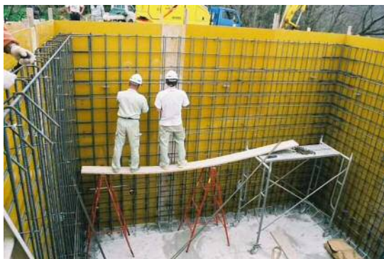
写真1 鉄筋配筋工程・請負工事
