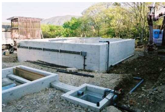
写真2 配管工事・自力施工 手前左: 沈殿分離槽 奥: 回分槽(100m 3 )
