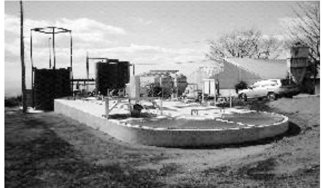
写真5 汚水処理施設全景
