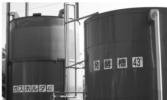
写真2 ガスホルダーと発酵槽
