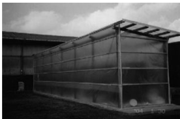
写真2 屋根の取替えとビニールで囲う
