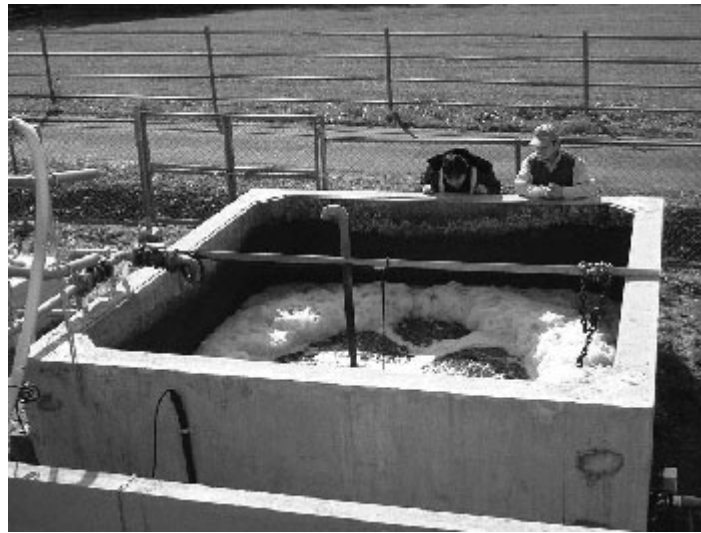
京都府畜産技術センターで運転中の回分式活性汚 泥法汚水処理
