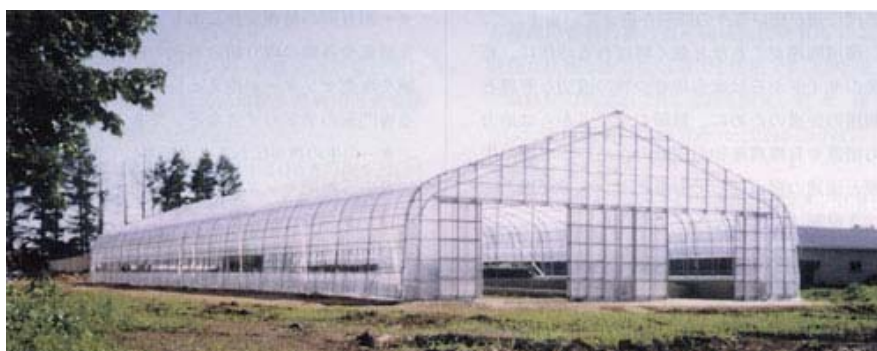
家畜ふんのハウス型堆肥化発酵処理施設
