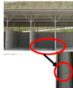
○ブローの整備による堆積+通気
