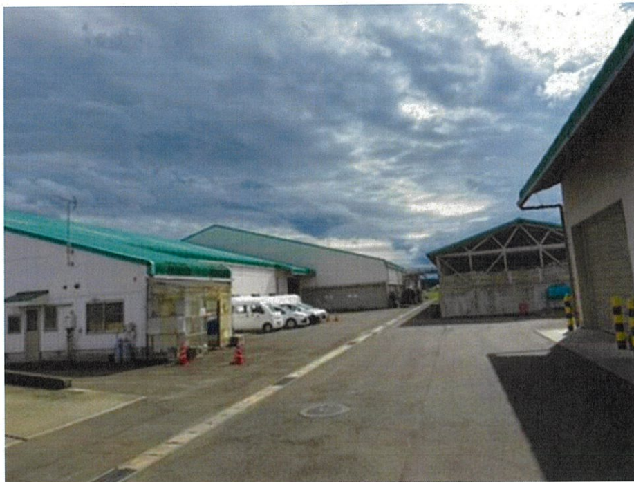
写真1 角田市農業の館の全景
