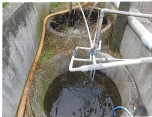
写真 12 最終沈殿槽
