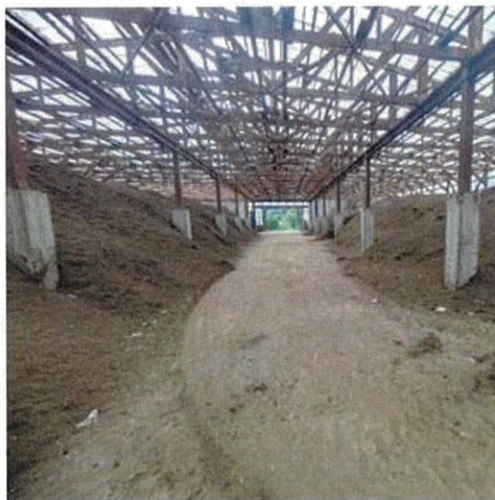
写真4 養生槽 (左側8槽)
