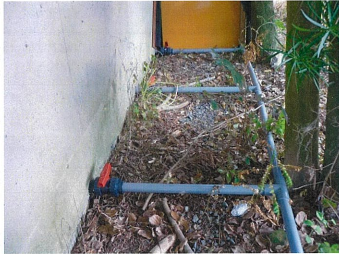
写真8 改善が求められる通気用配管(絞りを無くし配管を太くしたい)
