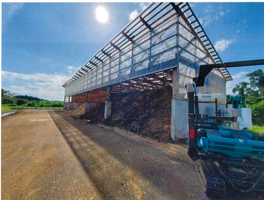
写真4 3つ区画分けされた堆肥舎の外観
