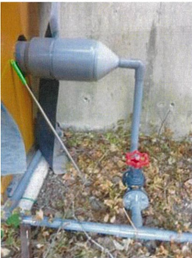
写真8 改善が求められる通気用配管(絞りを無くし配管を太くしたい)
