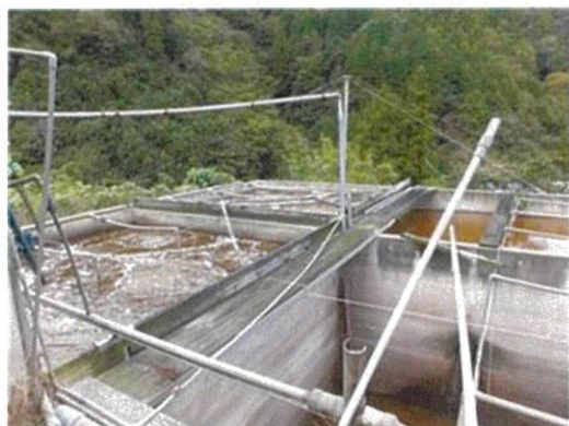
写真 11 曝気槽
