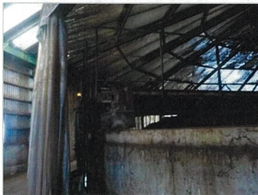
写真4 円形発酵槽内部(その1)
