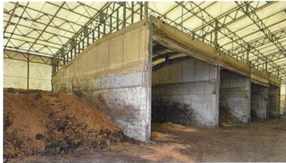
写真2 脱臭装置付きの1次発酵槽(1, 2週目)
