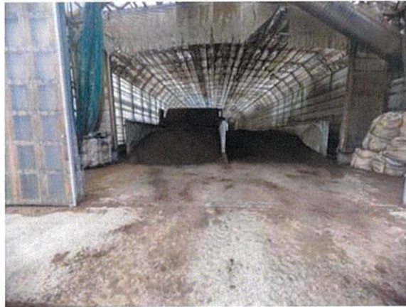
写真3 発酵槽2 (6m×50m×2槽)
