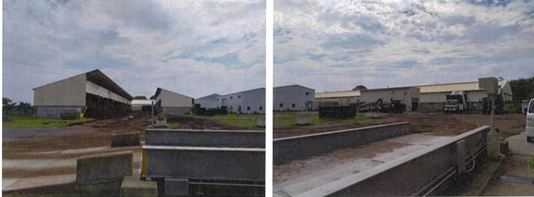
写真2 堆肥化処理施設の状況
