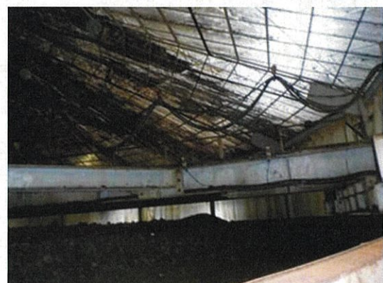
写真5 円形発酵槽内部(その2)
