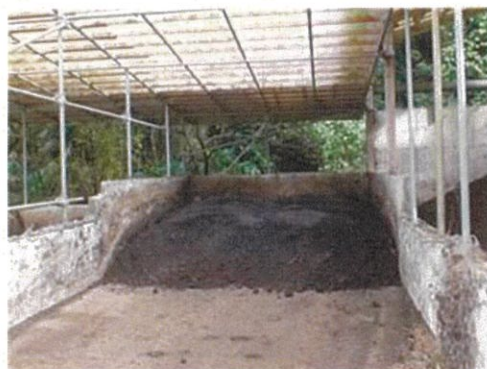
写真6 通気型堆肥舎(一次発酵槽) (プロアによる強制通気)
