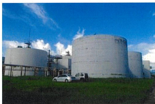
写真 8 消化槽
