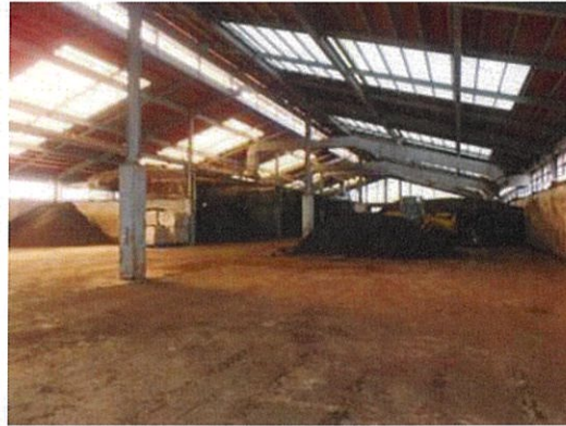
写真3 センター内部
