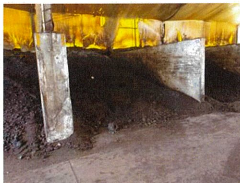
写真6 有機肥料の二次発酵槽
