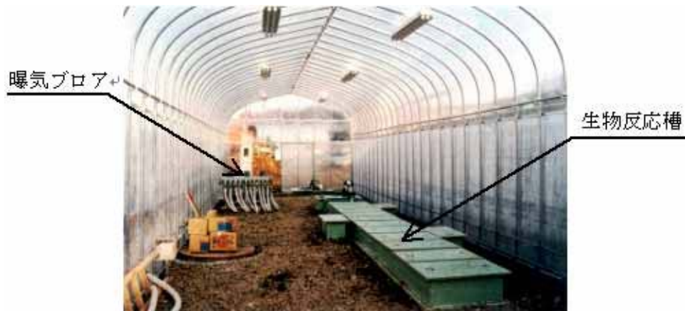
図2 実証試験設備外観
