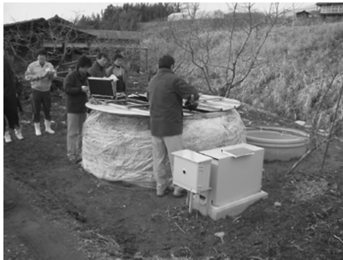
簡易曝気処理槽とブロワー(手前)
