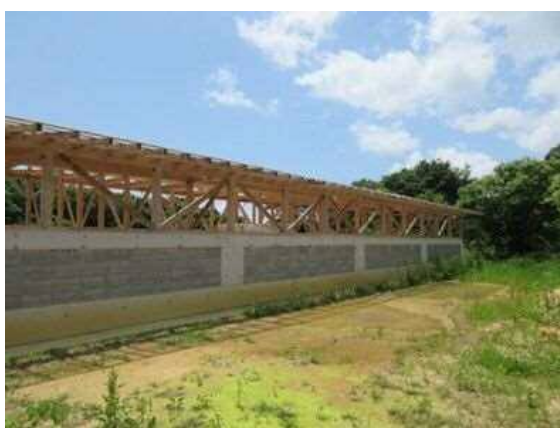
写真2 堆肥保管施設(外観)
