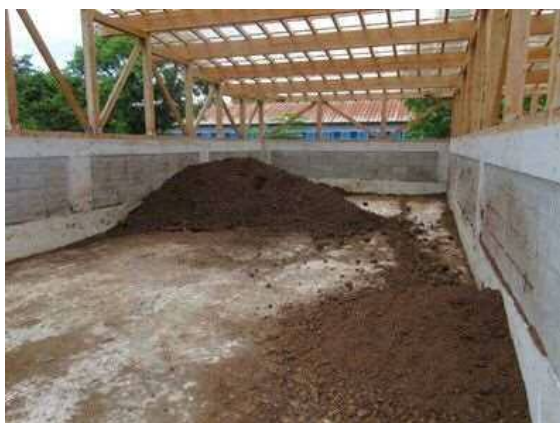
写真1 A肉用牛農家の堆肥保管施設(内部)
