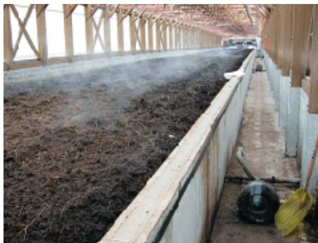
処理施設内部
