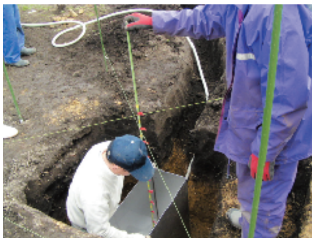
地下浸透水採取装置設置風景
