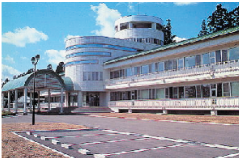
秋田県農林水産技術センター畜産試験場 研究管理棟
