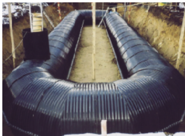
あおり型尿汚水処理施設
