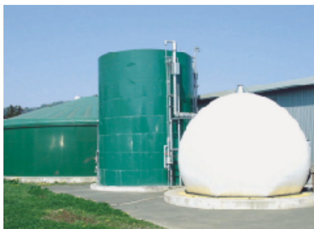
バイオガスプラント
