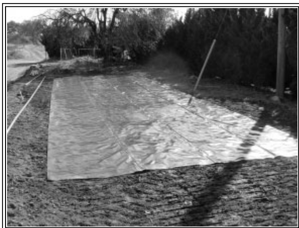
地面に遮水シートを張る
