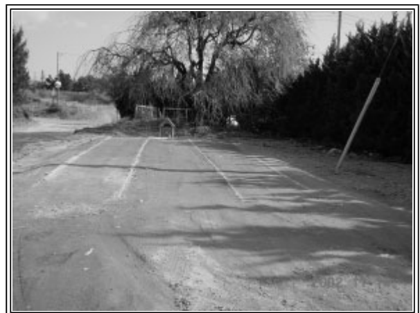
簡易堆肥盤の完成
