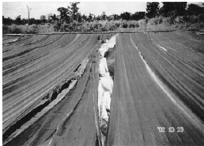
写真4 ふん尿貯留池(臭い発散防止のためビニールで覆う)
