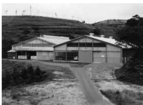
写真1 堆肥供給センター外観
