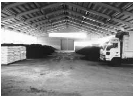
写真3 屋内堆積場内部
