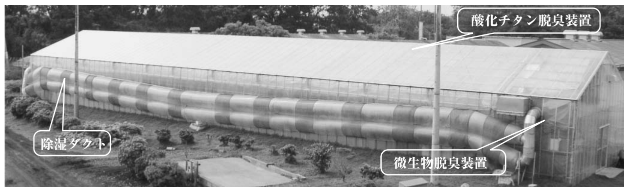
写真1 閉鎖型堆肥化ハウスの全景
